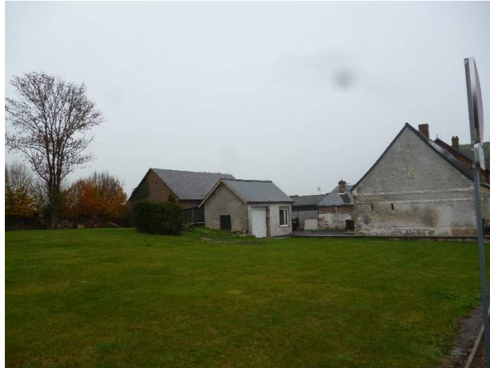
Figure 16 : Photo 3, Vue Nord-Ouest
