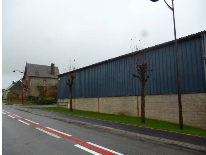
Figure 14 : Photo 1, Vue Sud-Ouest
